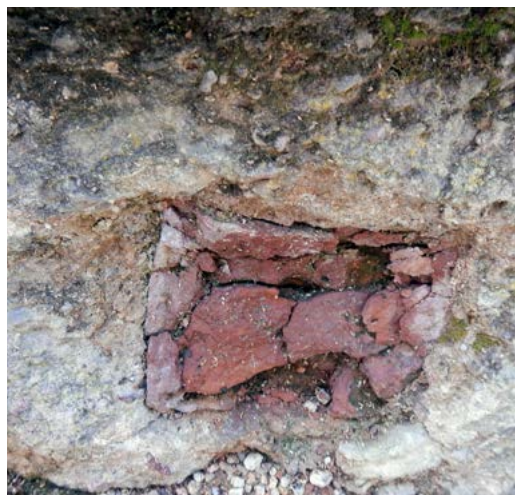
Zídka v parku poškozená biokorozí.
