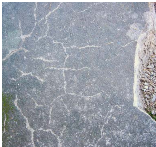
Nárasty mikroorganismů a poškození kamenného zábradlí v důsledku biokoroze.
