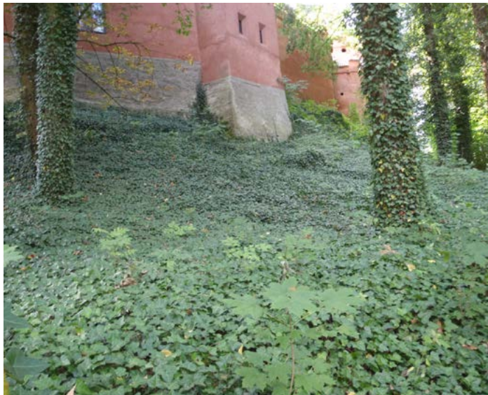
Nepropustné porosty břečtanu ( Hedera helix ), které se stále rozšiřují ve stinné části zámeckého parku v Červeném hrádku u Sedlčan.
