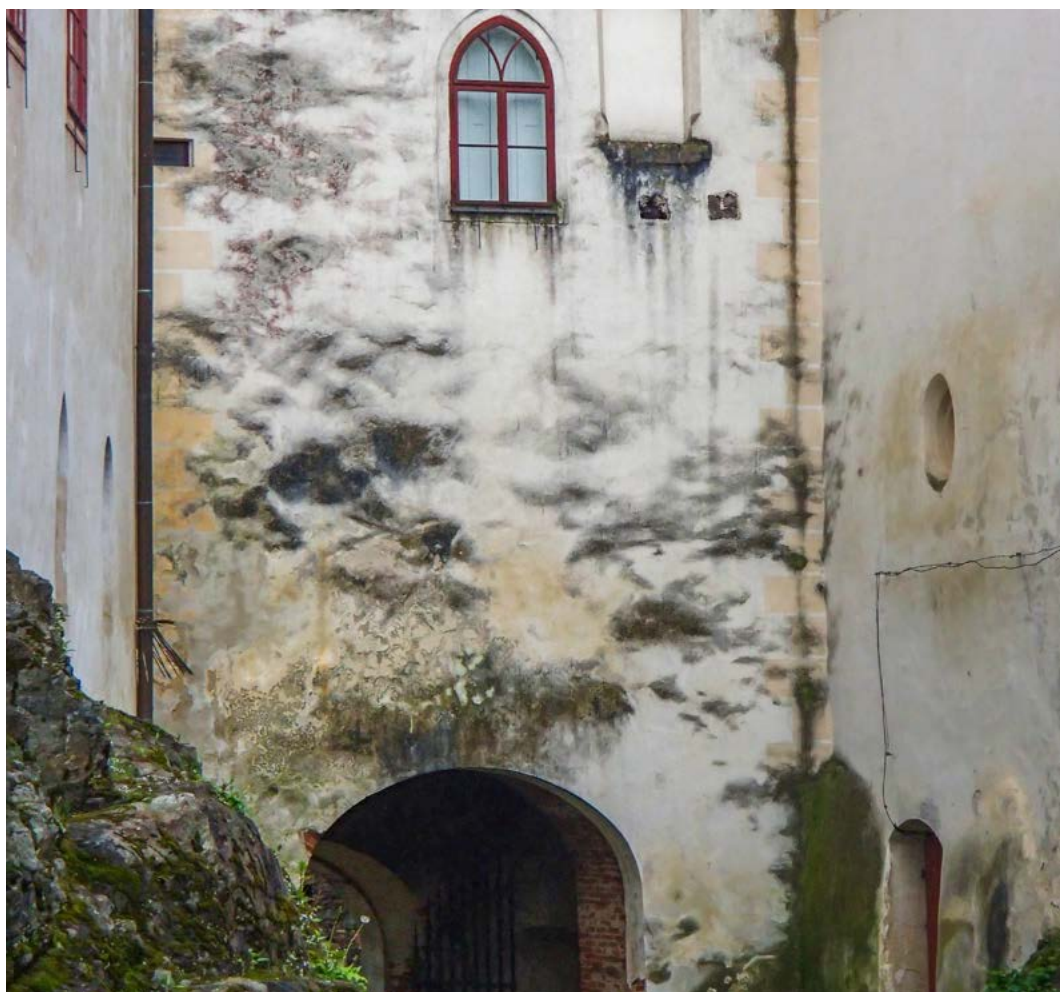
Biokoroze zdiva u vstupní brány hradu Bítov – řasy a plísňe.
