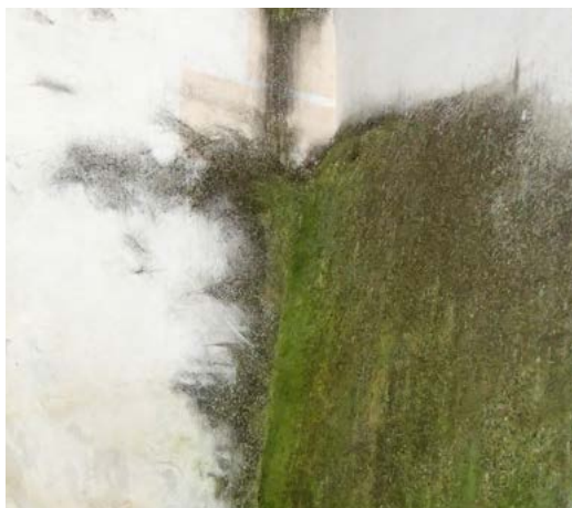
Nárosty řas a plísní na venkovních stěnách Průhonického zámku v roce 2017.
