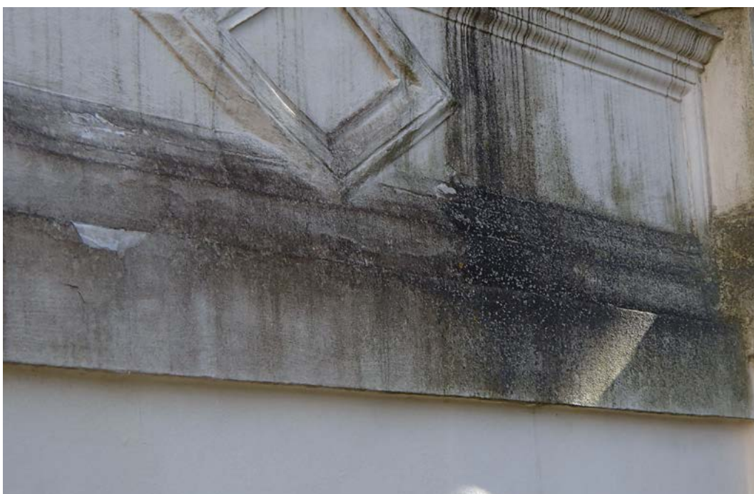
Biokoroze zdiva Průhonického zámku v roce 2017.
