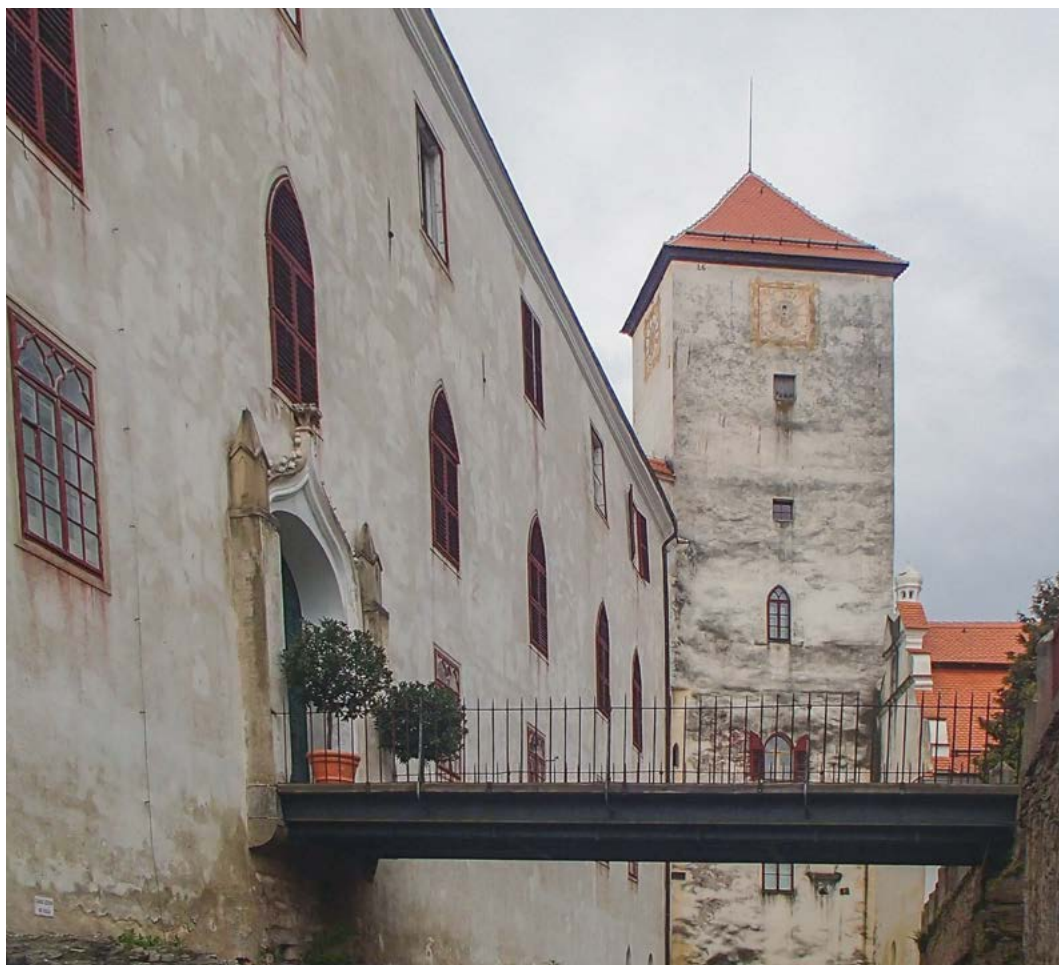
Poškozené zdivo hradu Bítov a nárosty plísní na věži.
