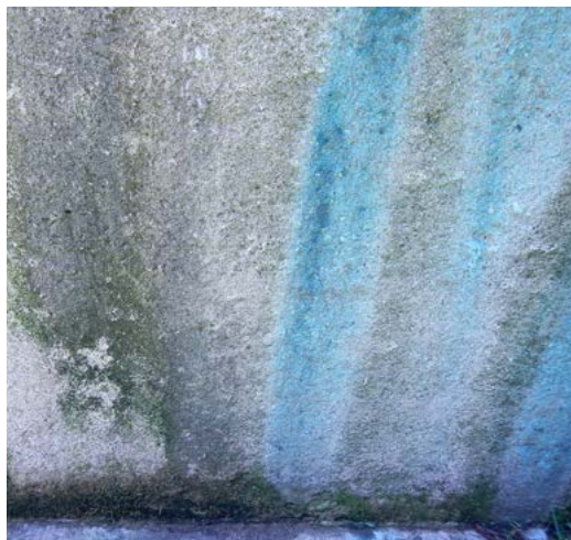
Biokoroze na podstavci pod sochou – vlevo nárost mikroorganismů, vpravo změna barvy.
